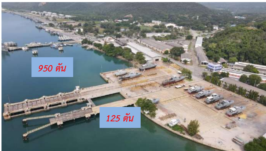
ภาพที่ 5 ซิงโครลิฟท์ที่นำเรือเข้าซ่อมทำขนาด 125 ตัน และ 950 ตัน
