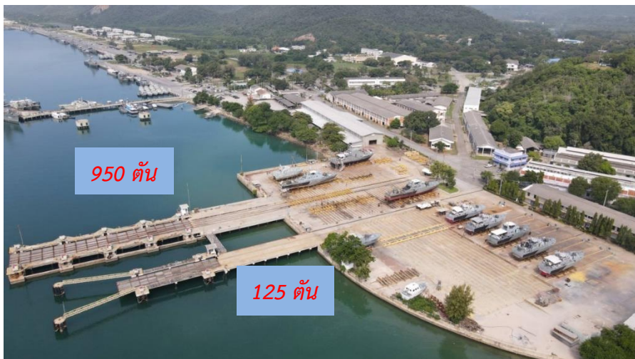
ภาพที่ 5 ชิงโครลิฟท์ที่นำเรือเข้าซ่อมทำขนาด 125 ตัน และ 950 ตัน
